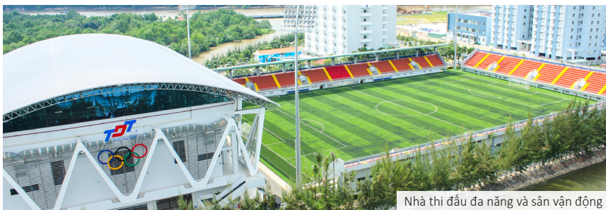
Nhà thi đấu đa năng và sân vận động
